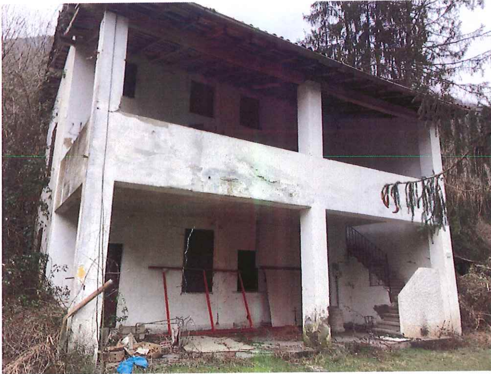
Vista prospetto "cascina Becai"
