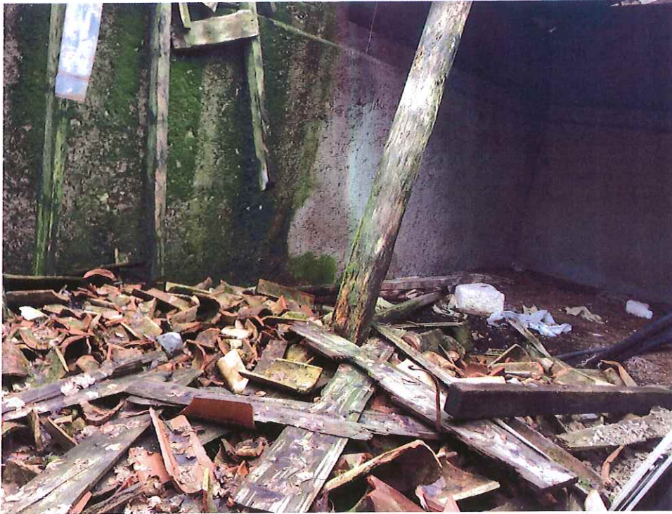
Vista interna fabbricato accessorio "cascina Becai"
