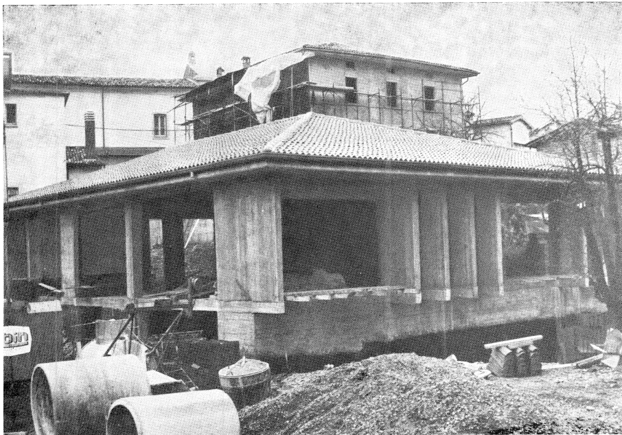
Altra veduta dei lavori di ampliamento della Scuola Elementare.
